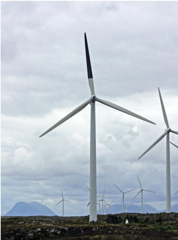
Ein schwarz bemaltes Rotorblatt einer Windenergieanlage im norwegischen Smøla-Windpark. Eine Vorher-Nachher-Untersuchung des Vogelschlages zeigte eine erhebliche Reduktion verendeter Vögel an den bemalten Anlagen.
