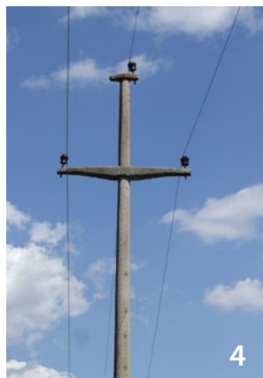
4 Tragmasten mit Stützisolatoren aus Keramik 10-20 kV (Topolchani ID231) – Totfund Rötelfalke F. naumanni – 4 Support pole with ceramic pin insulators 10-20 kV (Topolchani ID231) – found dead Lesser Kestrel F. naumanni
