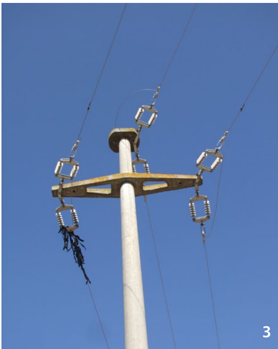
1 Abspannmasten mit ventraler Überbrückung und Stützisolator aus Komposit auf Mastkopf 10-20 kV (Dolneni ID162) – Totfund Schwarzstirnwürger L. minor – 1 Strain pole with horizontal insulator string, ventral jumper and composite pin insulator whit jumper cable on pole top 10-20 kV (Dolneni ID162) – dead Lesser grey shrike L. minor
