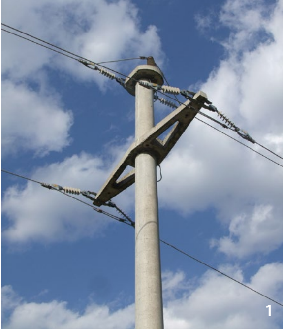
1 Abspannmasten mit ventraler Überbrückung und Stützisolator aus Komposit auf Mastkopf 10-20 kV (Dolneni ID162) – Totfund Schwarzstirnwürger L. minor – 1 Strain pole with horizontal insulator string, ventral jumper and composite pin insulator whit jumper cable on pole top 10-20 kV (Dolneni ID162) – dead Lesser grey shrike L. minor
