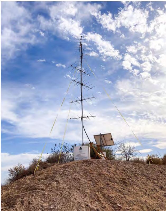
Abb. 2 Automatisierte Radioempfangsstation als Teil des Motus Wildlife Tracking System (Taylor et al. 2017) in Israel mit denen der Abzug aus dem Rastgebiet sekundengenau aufgezeichnet werden kann.
